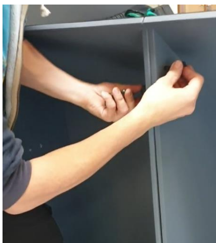
Abbildung 11: Schließen der Counter mit Rändelschraube und Mutter
