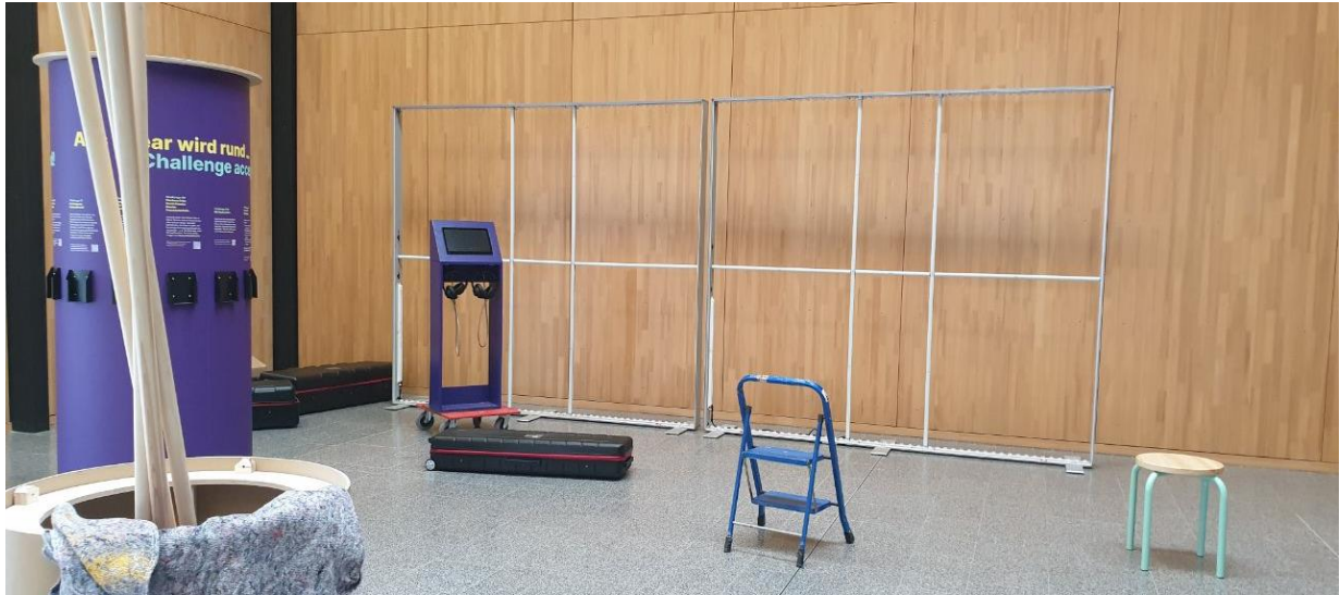
Abbildung 49: Montiertes Rahmenprofil der Textilleuchtwand
