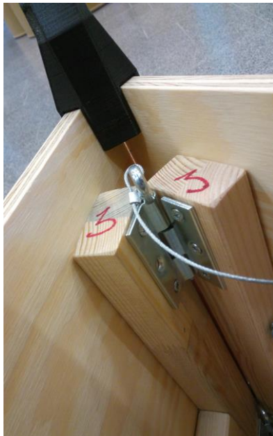
Abbildung 31): Sockelplatten mit Theaterscharnieren verbunden (nach Nummerierung 1 bis 3)
