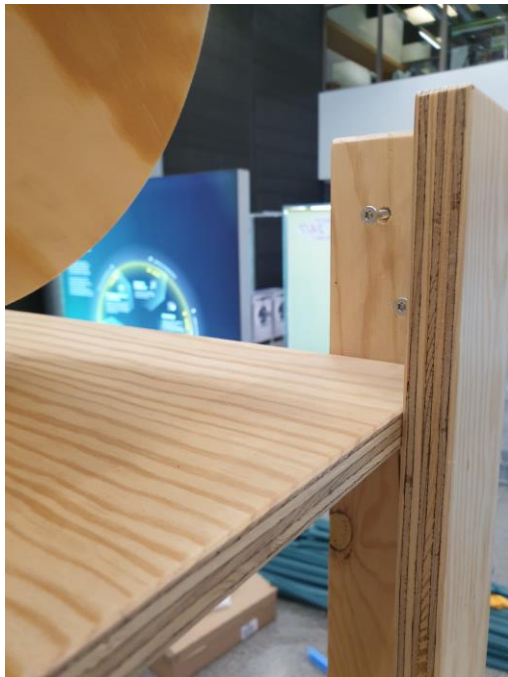
Abbildung 70: Holzschrauben zum An- und Abschrauben der Schilder der Station 02.06.
