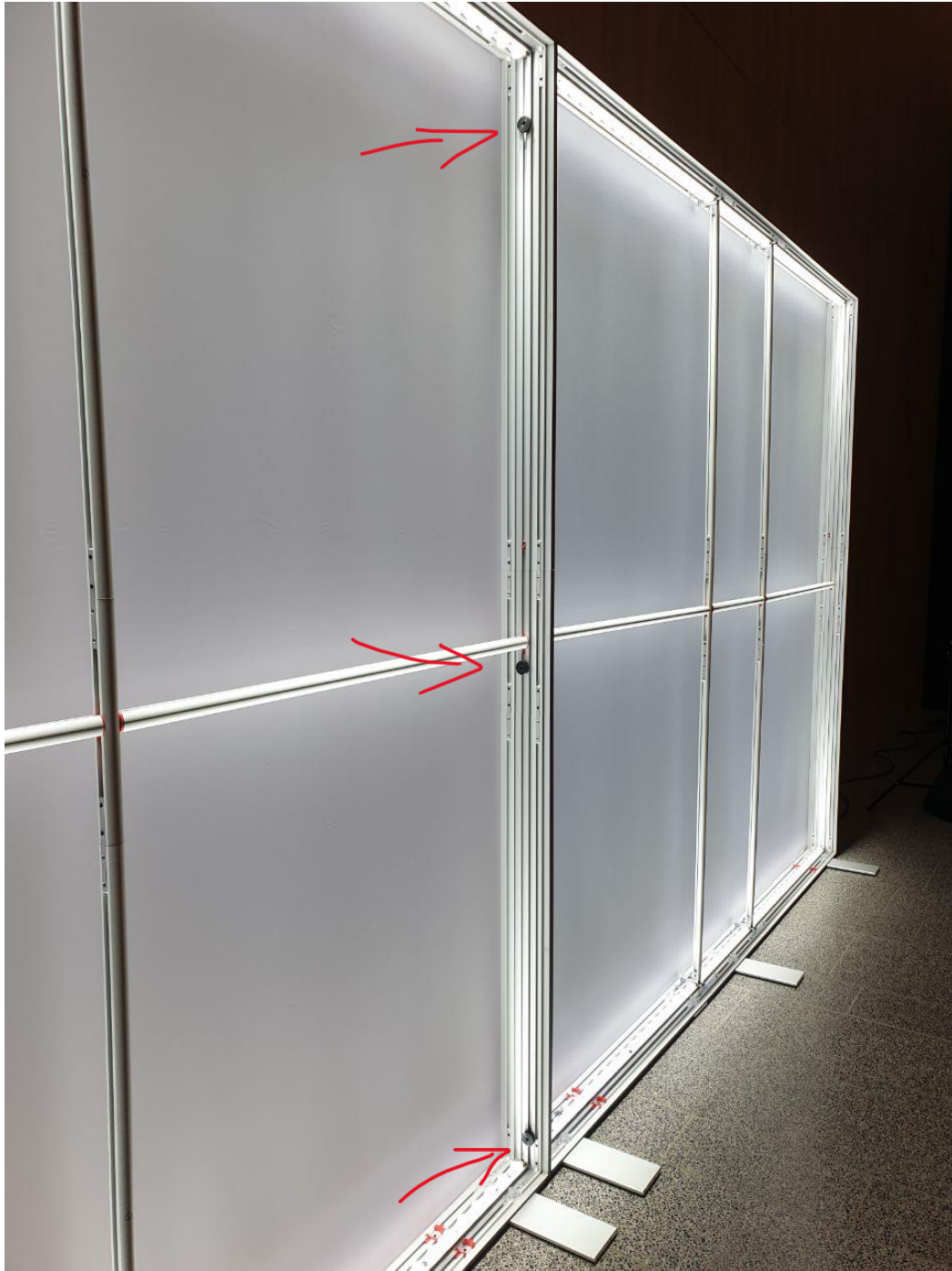
Abbildung 51: Verbindung der Rahmenelemente der Textilleuchtkästen über Rändelmuttern und -Schrauben
