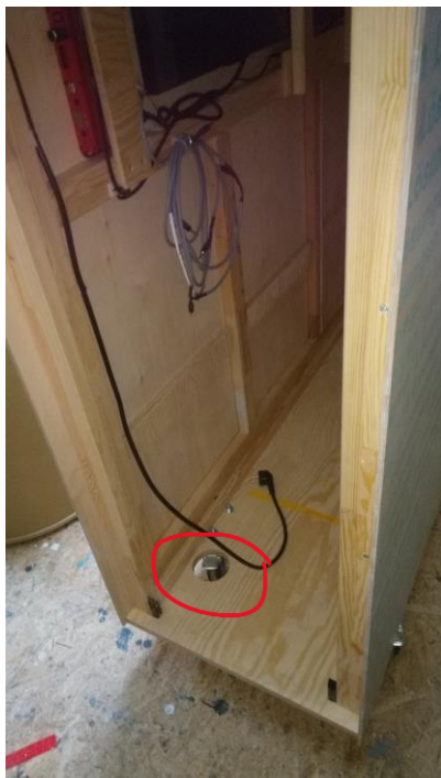
Abbildung 28: Öffnung zum Durchführen der Stromzufuhr
