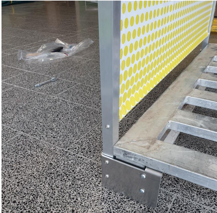
Abbildung 12: Aufgebaute Rückwand mit Klemmplatten verschraubt
