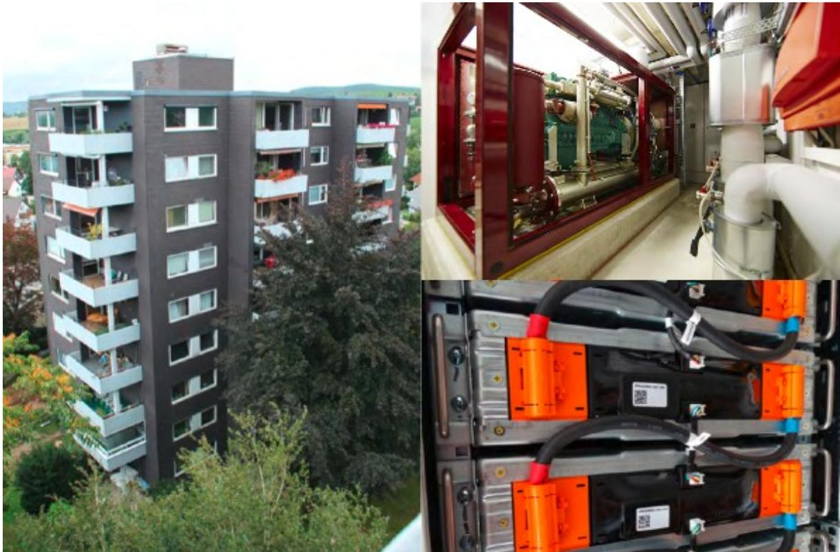
Abbildung 80: Eines der zwei Hochhäuser (links) sowie KWK-Anlage (rechts oben) und Batteriespeicher im Gebäudenetz Flein, „Max & Moritz“ (Bildquelle: [KEA-BW Leitfaden KWK in der Wohnungswirtschaft](#))
