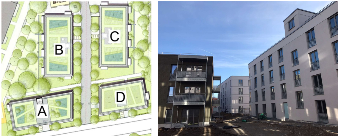
Abbildung 3-1 Links: Übersicht über die vier Wohngebäude [©Münchner Wohnen], rechts: nahezu fertiggestellte Gebäude (links: Teil von Haus B, rechts vorne: Haus A, rechts hinten: Haus D)
