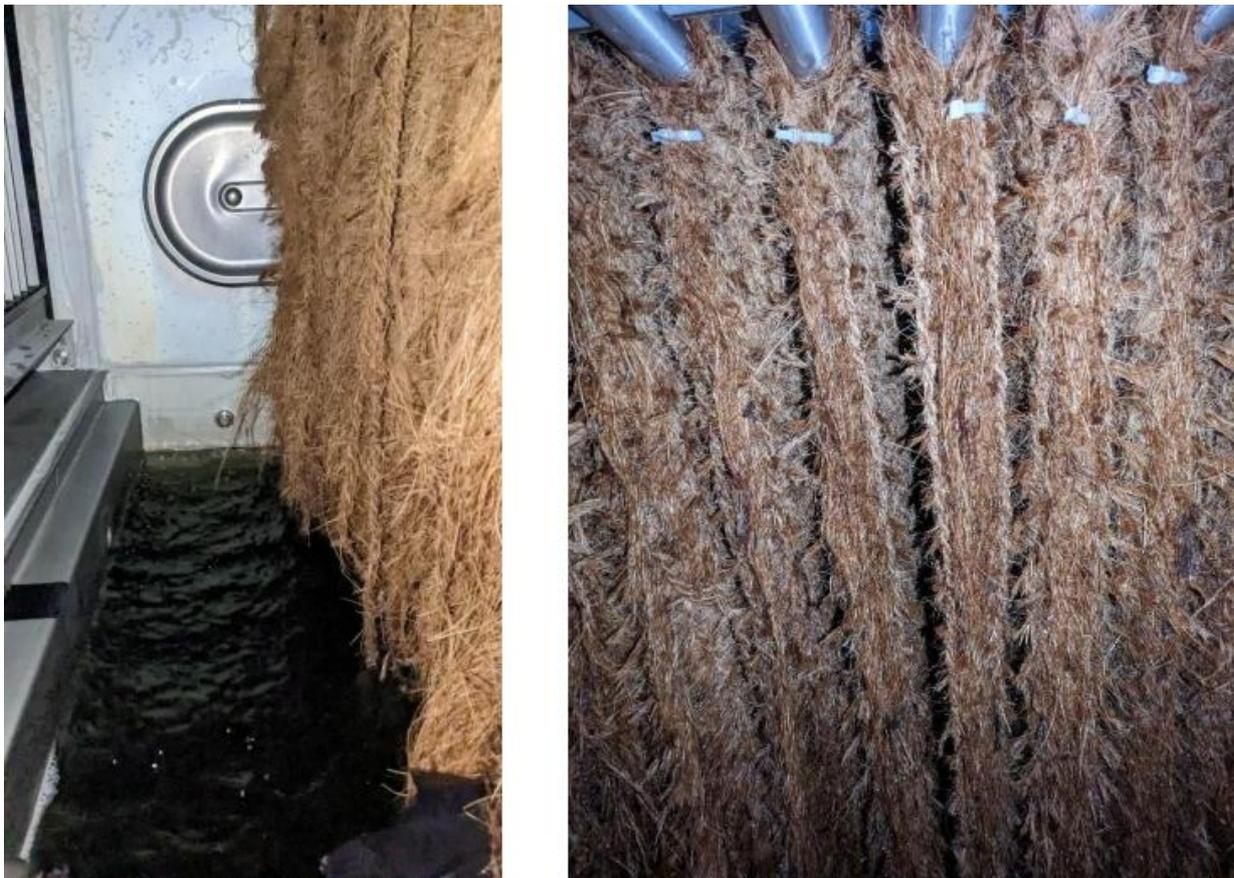
Abbildung 6: Trägermaterial Kokosfasermatten aufgehängt auf Träger- und Befeuchtungsrohren
