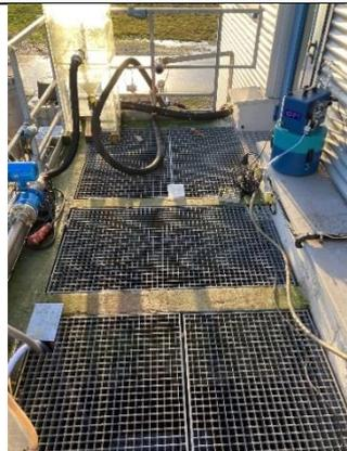
Ablauf NK 1 und 2 mit Messtelle und automatischem Probennehmer (PN 4)
