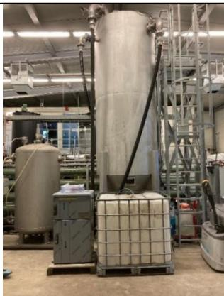
Sandfilter, IBC für Spülwasser und automatischem Probennehmer (PN 6 & 8)
