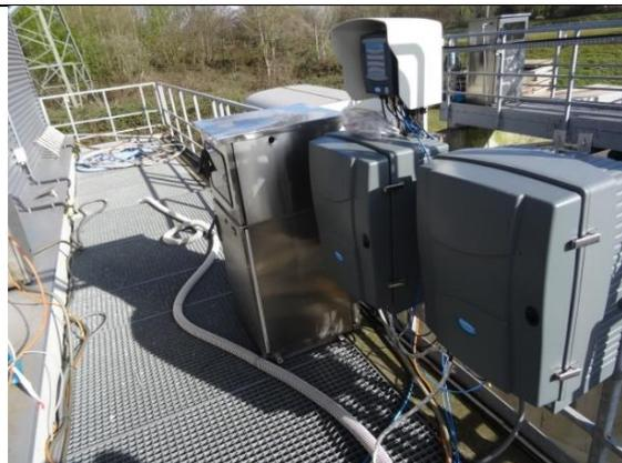
Flockungsreaktor mit Messtelle und automatischem Probennehmer (PN 5)
