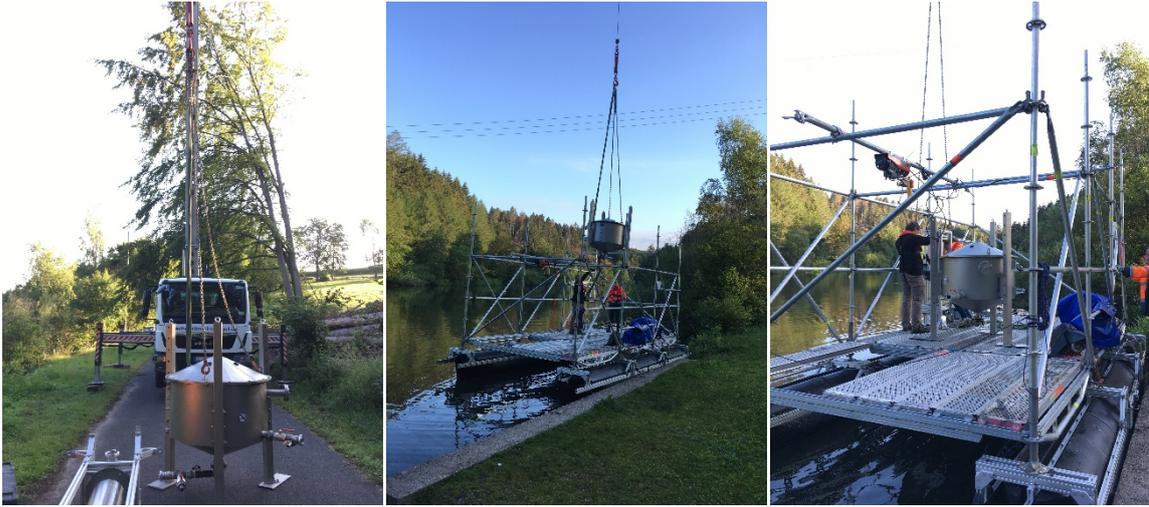
Abbildung 42: Fertigstellung der Arbeitsplattform mithilfe eines Autokrans
