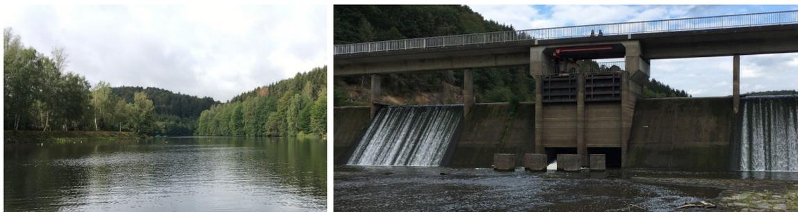
Abbildung 3: Wupper-Vorsperre (links) und Absperrbauwerk der Wupper-Vorsperre mit überströmter Hochwasserentlastung am 24.08.2020.
