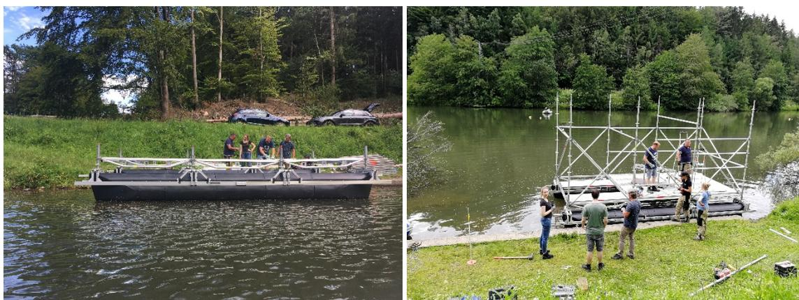
Abbildung 40: Aufbau der Arbeitsplattform auf dem See
