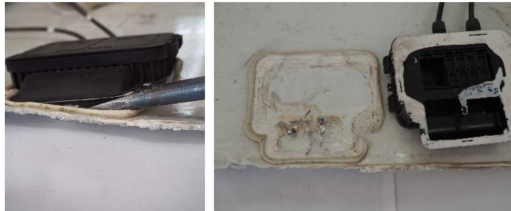
Abbildung 8: Demontage einer Anschlussdose.
