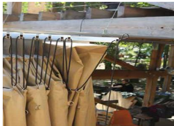
Abb. 12: Flexible Räume, innen Lärmschutz und Wärmedämmung durch Filz
