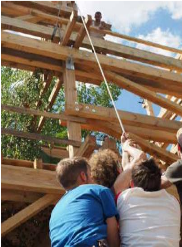
Abb. 11: Bau des zweiten Geschosses, Muskelkraft statt Kran
