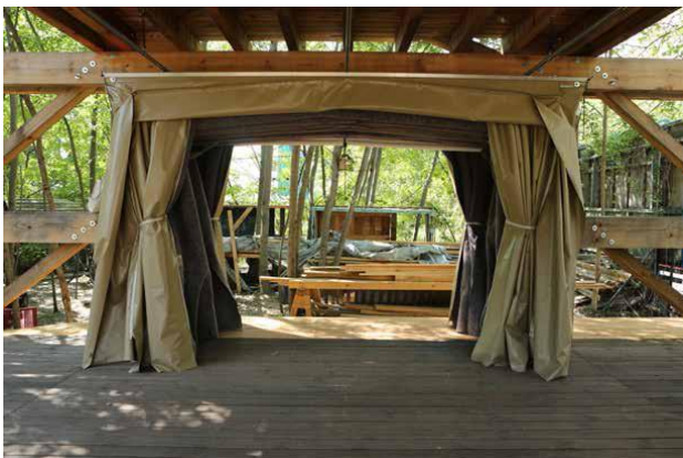
Abb. 12: Flexible Räume, innen Lärmschutz und Wärmedämmung durch Filz
