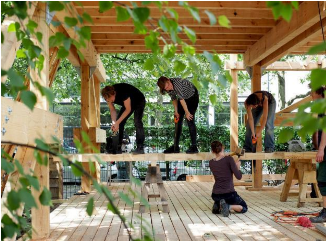
Abb. 2: Teilnehmer des zweiten Bauworkshops beim Bau der Treppe
