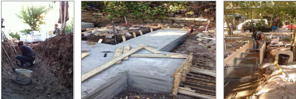
Abb. 7: Fundamente-Aushub und Bewehrung
