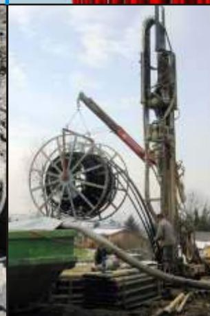
Einbringen der Sonden und verfüllen der Bohrlöcher
