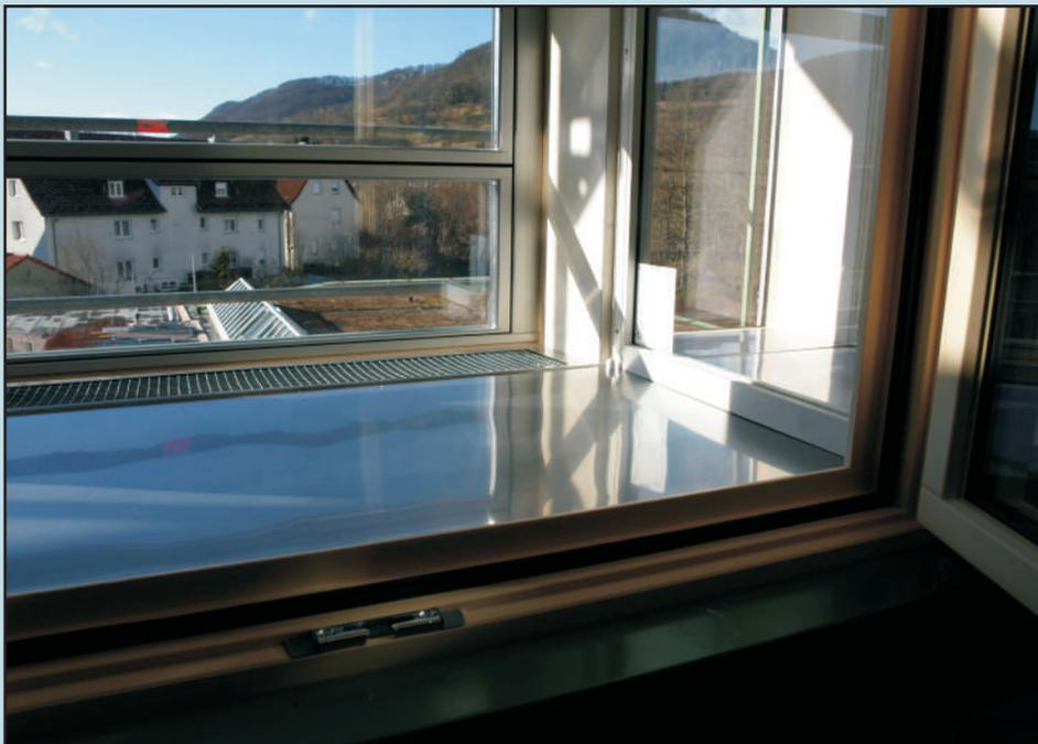
Ausgeführtes Detail in der Muster- bzw. Testfassade: Fensterbrüstung mit polierter Edelstahlplatte, die (nach dem Prinzip Einfallswinkel = Ausfallswinkel) als Lichtumlenksystem zur Tageslichtausleuchtung der Klassendecke im hinteren Bereich beiträgt.
