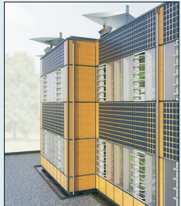
Die in das Stahlfachwerk des Absorberkollektoren-Doppeldachs eingelegten nach Süden geneigten Wärmekollektoren (Produkt Energie Solaire) mit einer Fläche von 1210 qm erbringen einen Eintrag von erneuerbare Wärmeenergie von 610 000 kWh/Jahr.
