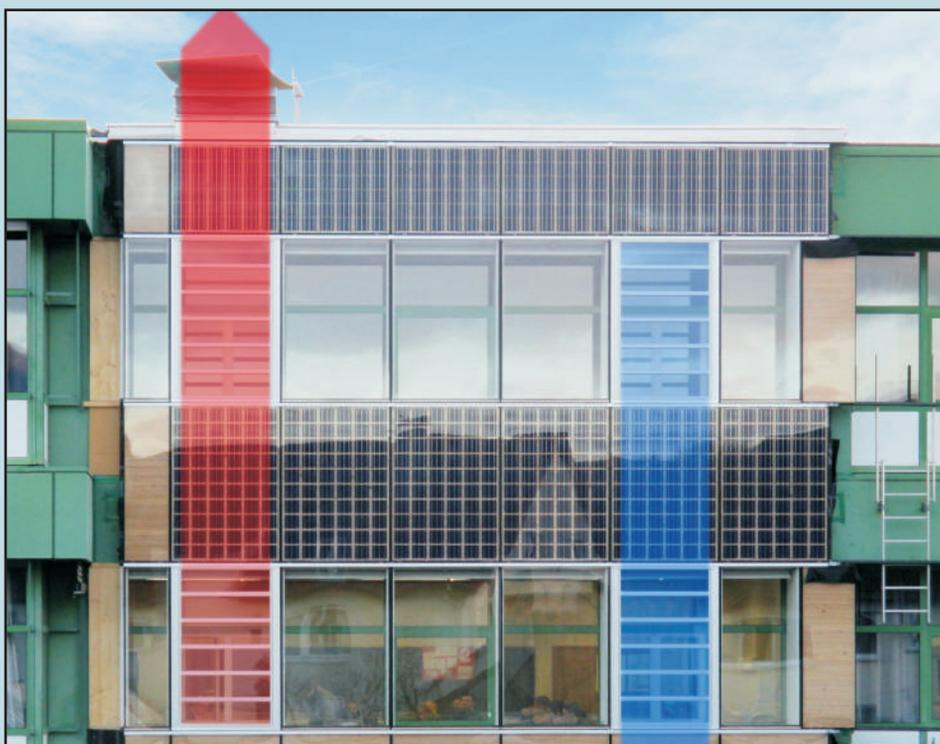
Anstatt die gewünschten Luftströme zur optimalen Frischluftversorgung der Klassen in einem Simulationsmodell zu ermitteln, wurde eine Muster- bzw. Testfassade im Maßstab 1 : 1 zweigeschossig über eine Klassenbreite gebaut:
