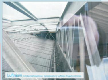
Luftraum mit Absorberkollektoren, Deckenglaschicht und vertikaler Tügelkonstruktion
