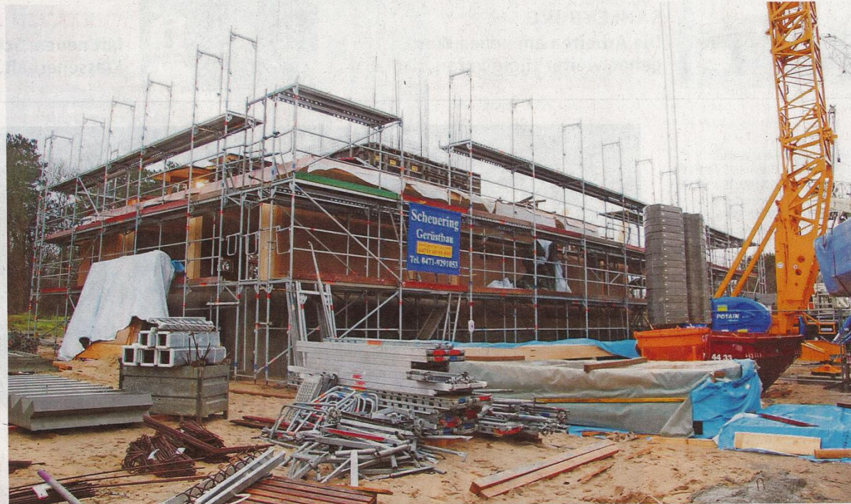
UNESCO-Weltnaturerbe Wattenmeer-Besucherzentrum: Die Gründungsarbeiten und der Rohbau im Erdgeschoss sind abgeschlossen.
