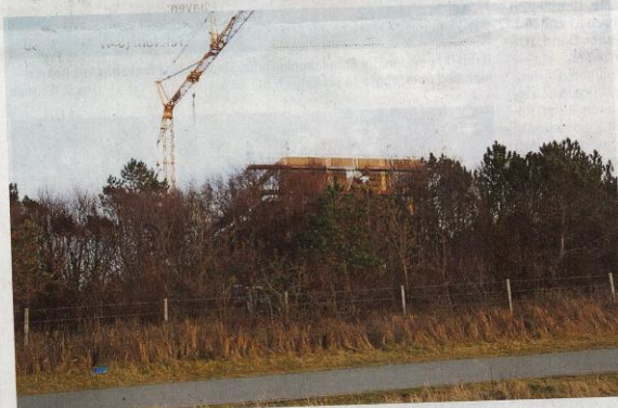
Noch ist das im Bau befindliche WattBz in Sahlenburg hinter einem Riegel aus Gehölzen verborgen. In den kommenden Tagen soll sich der „Vorhang“ lüften. Foto: Potschka
