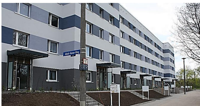
Abbildung 27: Jakob-Kaiser-Ring in Erfurt nach der Sanierung (Foto: ISP 2014)
