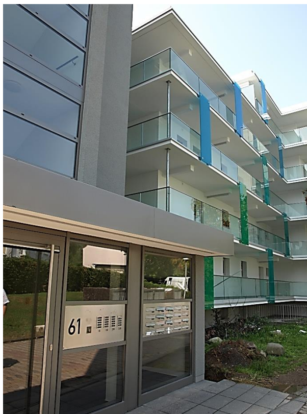
Abbildung 29: Quellhofstraße in Kassel während der Sanierung (Foto: ISP 2013)
