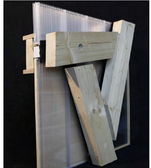
B46\_Detailmodell Fassade mit transparentem, transluzentem und geschlossenem Feld zur Aussteifung
