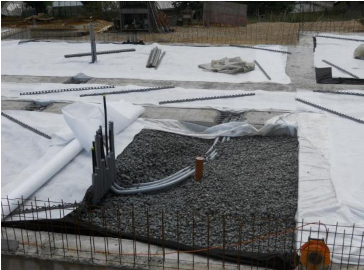
**Bild 5: Wärmedämmung unter der Bodenplatte mit Glasschaumschotter, Architekturbüro W. Haase**
