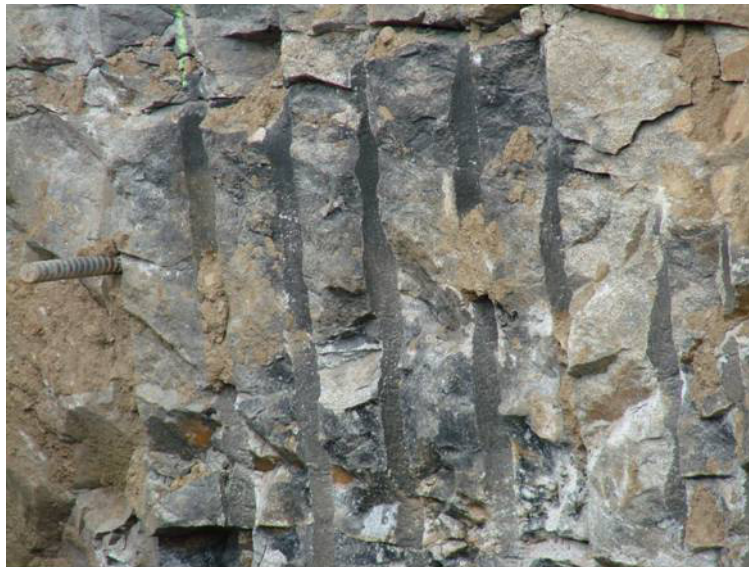
Bild 6.5: Spaltsprengung mit Bruchbildung durch Überlagerung der Machkonusse und den sich sekundär auf der Spaltfläche ausgebreiteten Schwaden
