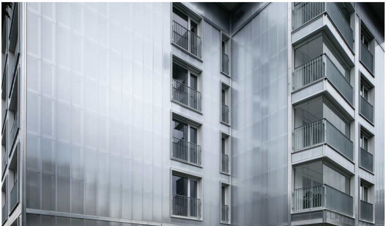
Abb. 45:Fassade des Punkthauses nach der Sanierung
