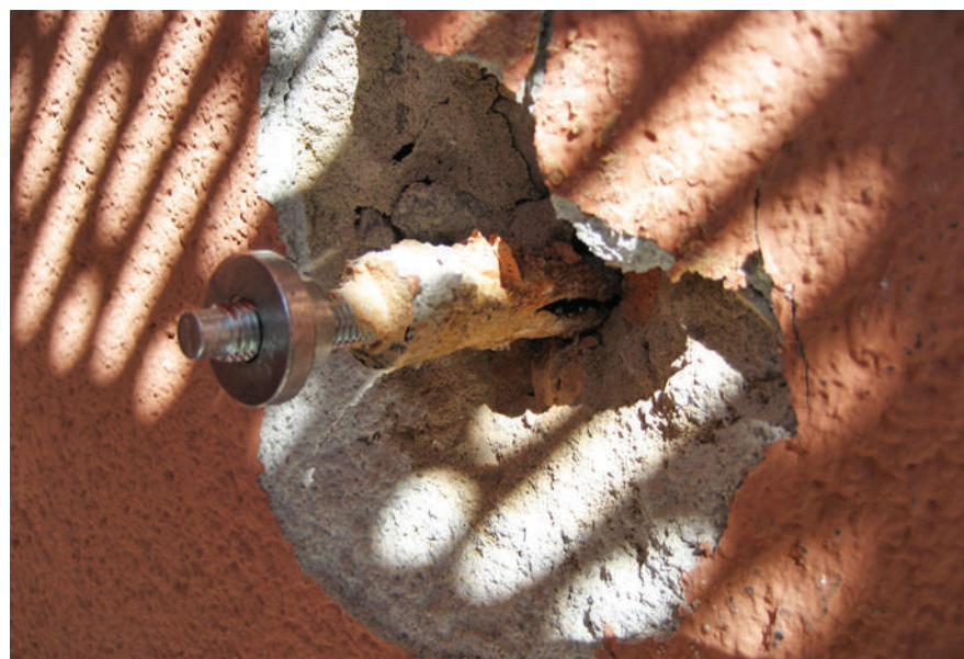
Abb. 41: Dübelauszugsversuche Aussenwand Bestand
