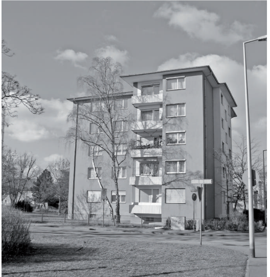
Abb. 5: Bestandsgebäude Ansicht Nordost
