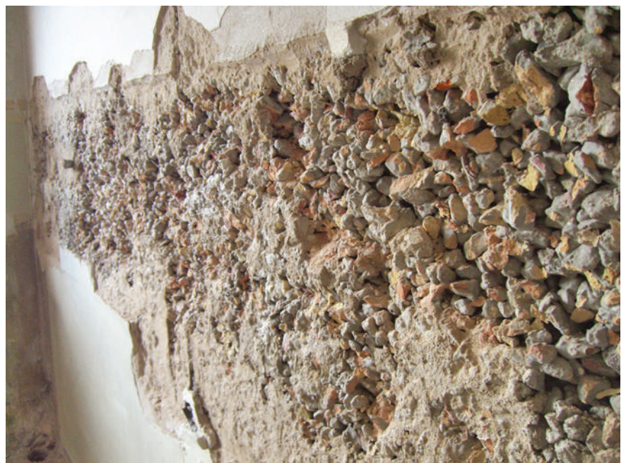
Abb. 9: Wand aus Schüttbodyeton
