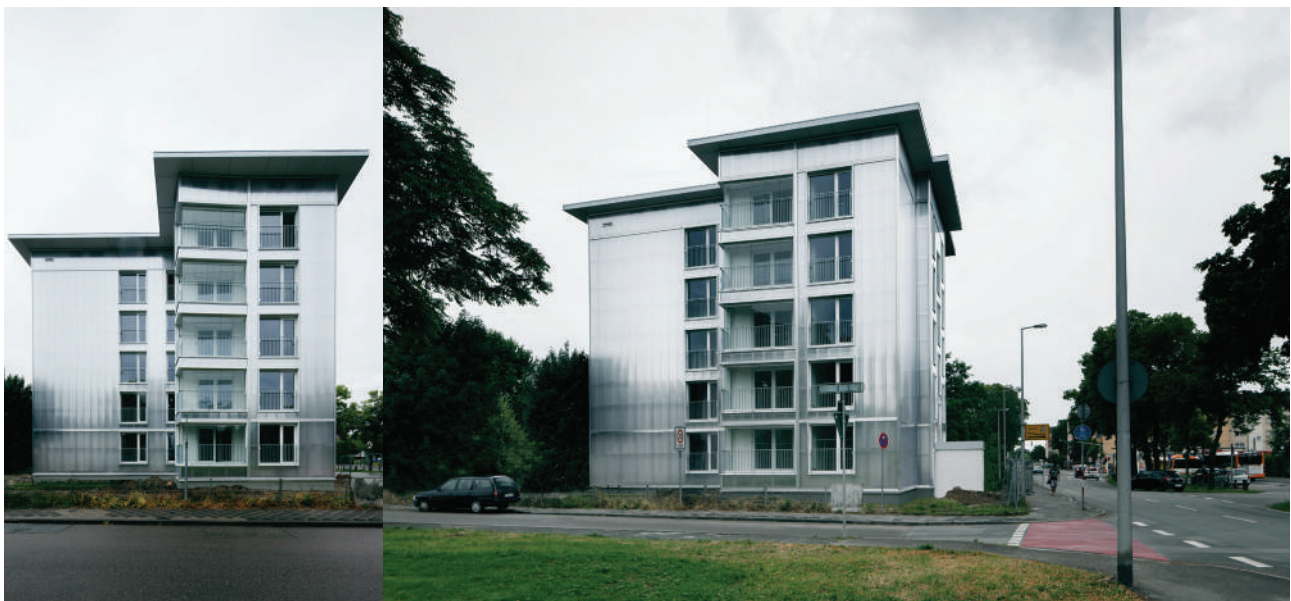
Abb. 2: Punkthaus nach der Sanierung
