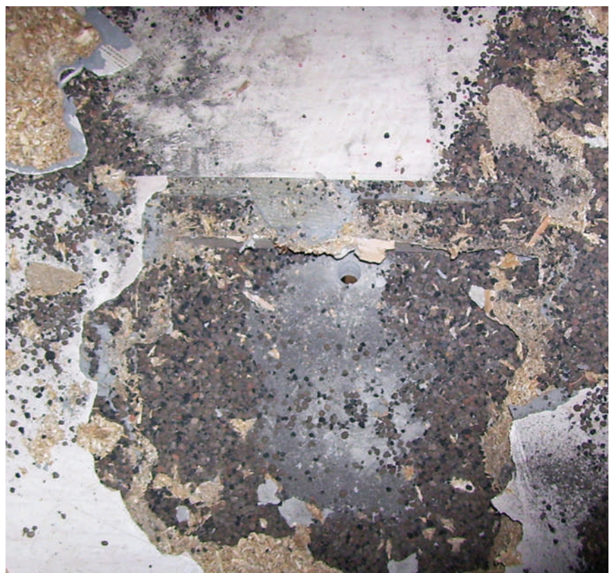
Abb. 42: Prüfbohrung Bestandsdecke
