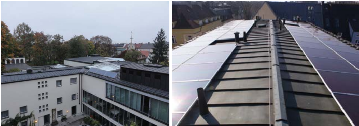
Bild 9: Nachträglich angebrachte Solaranlage zur sommerlichen Warmwasserbereitung im R-Trakt sowie Photovoltaikanlage auf dem Gästehaus, Architekten KuK
