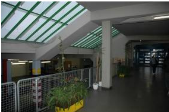
Abb. 28: Bibliothek, Beleuchtung notwendig trotz Dachverglasung
