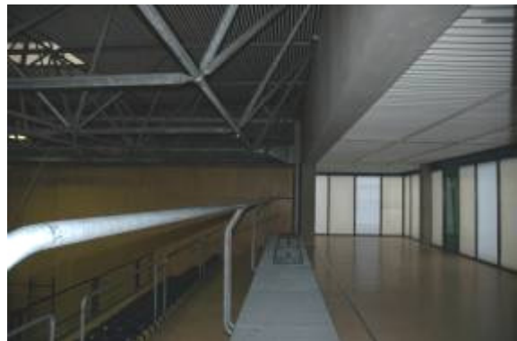
Abb. 17: Zu wenig Licht durch die Oberlichter - dauernder Kunstlichteinsatz notwendig
