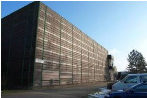
Abb. 15: Außenansicht Turnhalle, fensterlos
