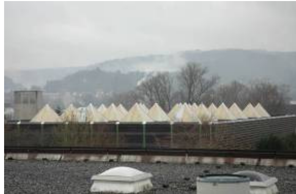
Abb. 16: Flachdach Turnhalle mit Lichtpyramiden
