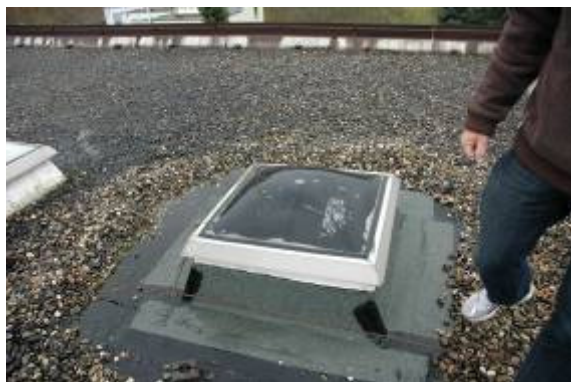
Abb. 23: abgeklebte Lichtkuppel
