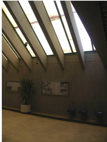
Abb. 38: Dachverglasung Foyer Turnhalle
