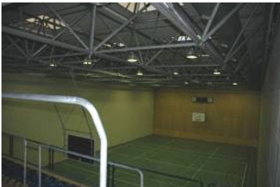
Abb. 17: Zu wenig Licht durch die Oberlichter - dauernder Kunstlichteinsatz notwendig
