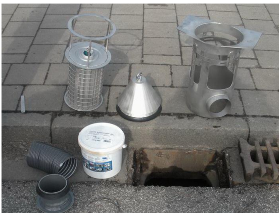
Abb. 11: INNOLET G Bauteil, Version für den Einbau vor Ort
