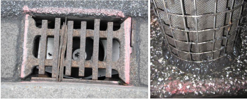
Abb. 43: INNOLET G eingebaut in Hamburger Trumme, Filterpatrone ausgebaut
