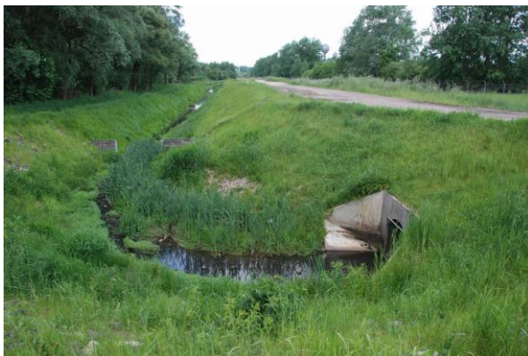
Abb. 23: Auslass der Regenkanalisation (Regensiel) in Entwässerungsgraben
