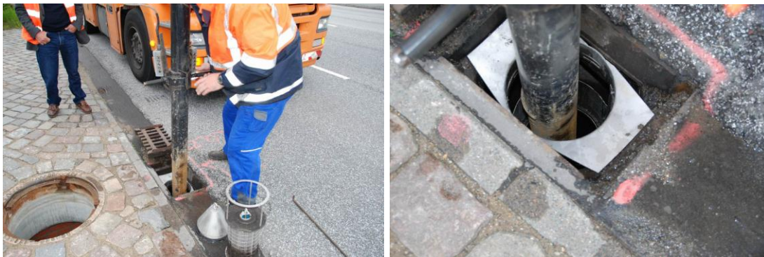
Abb. 44: Wartung der Hamburger Trumme mit INNOLET G mit Hilfe eines Saugwagens von Hamburg Wasser
