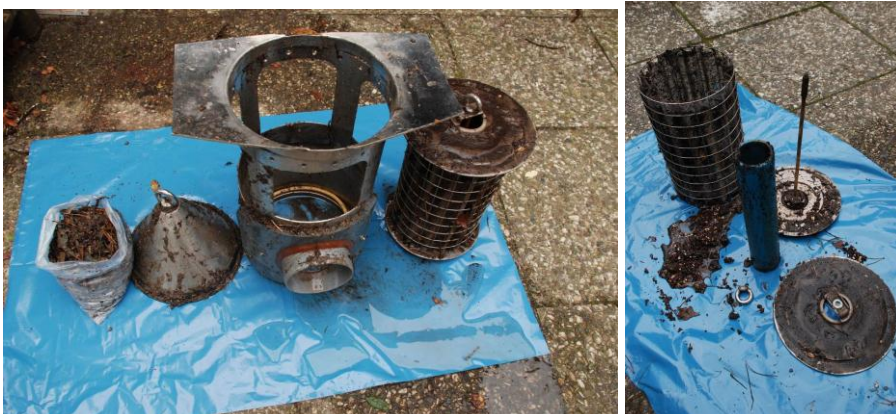
Abb. 15: Ausbau des Filters
