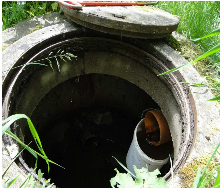
Einleiten von Wasser aus dem Eliminierungsbecken ins Nachreinigungsbecken; Ablauf des Nachreinigungsbeckens; Ablaufschacht mit Eimer zur Probeentnahme
