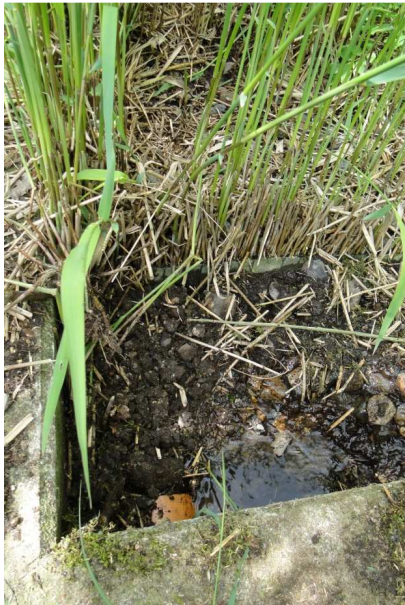
Einleiten von Wasser aus dem Eliminierungsbecken ins Nachreinigungsbecken; Ablauf des Nachreinigungsbeckens; Ablaufschacht mit Eimer zur Probeentnahme
