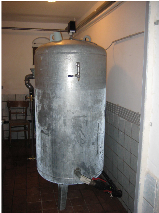
Übergang Aufbereitung (links) – Druckwindkessel (rechts) mit Druckerhöhungspumpe
