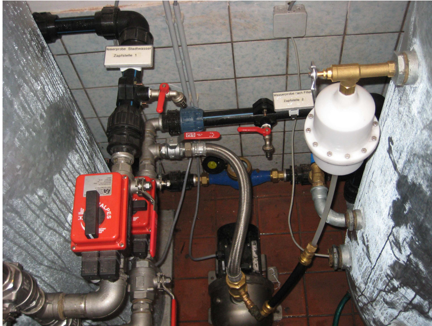
Übergang Aufbereitung (links) – Druckwindkessel (rechts) mit Druckerhöhungspumpe
