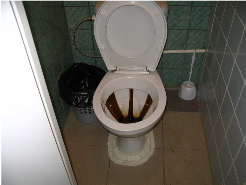
Toilettenschüssel mit Eisenoxidbelägen
