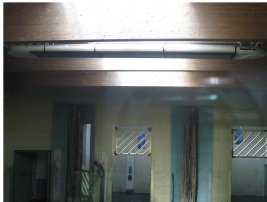
Abbildung 14: Infrarotstrahler im Elefantenhaus
