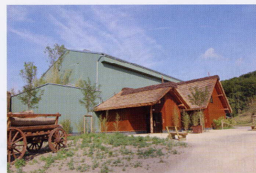
Per Blockheizkraftwerk werden Affen- und Südamerikahaus mit Strom und Wärme versorgt.
