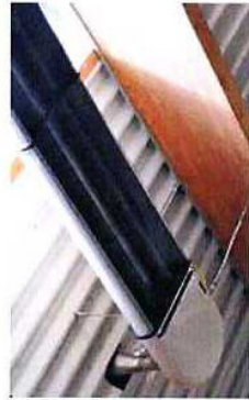
Infrarotstrahler im Elefantenhaus
