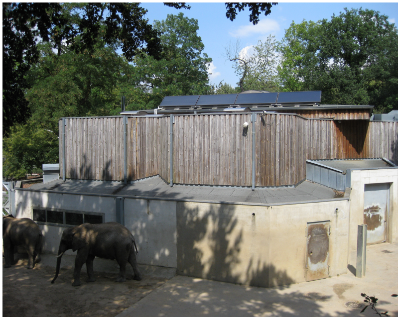
Abbildung 4: Solaranlage auf dem Elefantenhaus
