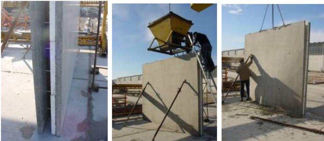
*Abb. 34: Verarbeitungsversuche von Sandwichwänden auf der Baustelle, Füllen von 3 m hohen Wänden mit Beton*
