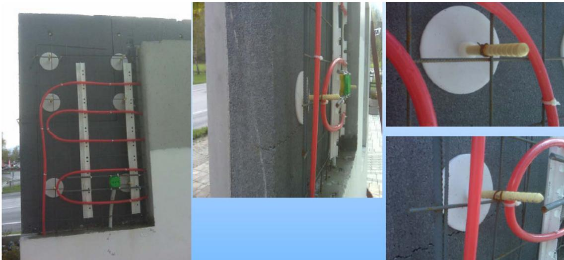
Abb. 47: Integration von Heizungssystemen in Fertigteilwände
