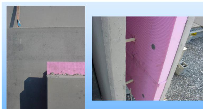
*Abb. 36: Ausführung von Decken- und Wandanschlüssen auf einer Baustelle (Die Dämmschicht ist sichtbar für die Anschlüsse vorgefertigt.)*
