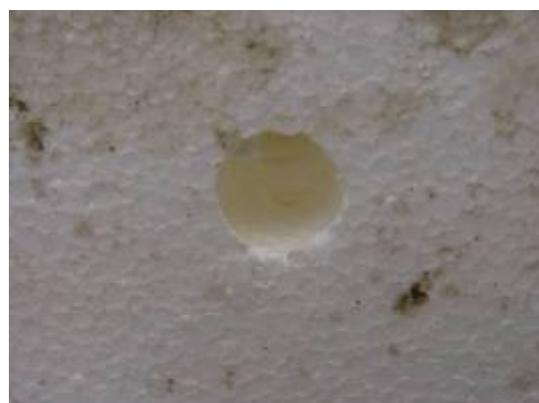
*Abb. 32: Bilder aus dem Einsatz des Werkzeugs zum Einbringen von Löchern in Dämmstoffplatten für ComBAR®-Stäbe*
