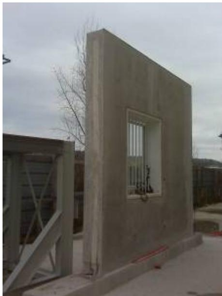
*Abb. 35: Innengedämmte Wand mit Fenster auf Baustelle (Versuchswand zu Abb. 21), ein Projekt wird derzeit in Frankreich dazu umgesetzt*
