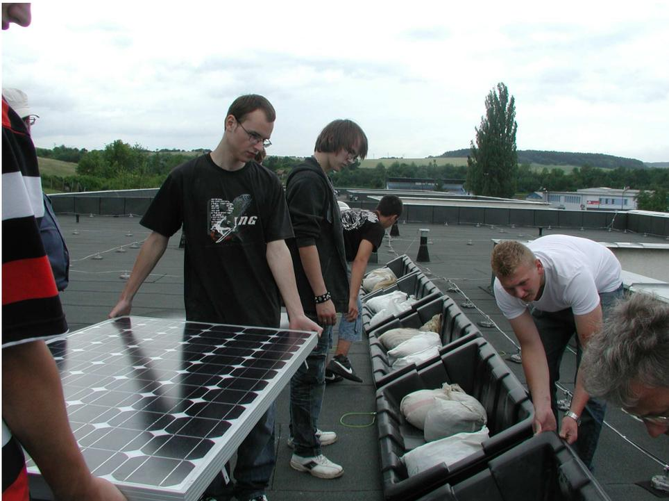
**Abbildung 3-18 Montage der Module auf dem Flachdach**
