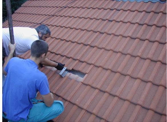
**Abbildung 3-4 Unterweisung zur Befestigung von Dachhaken für die Kollektoren**
