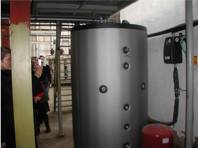
**Abbildung 3-14 Neuer Trinkwasserspeicher**
