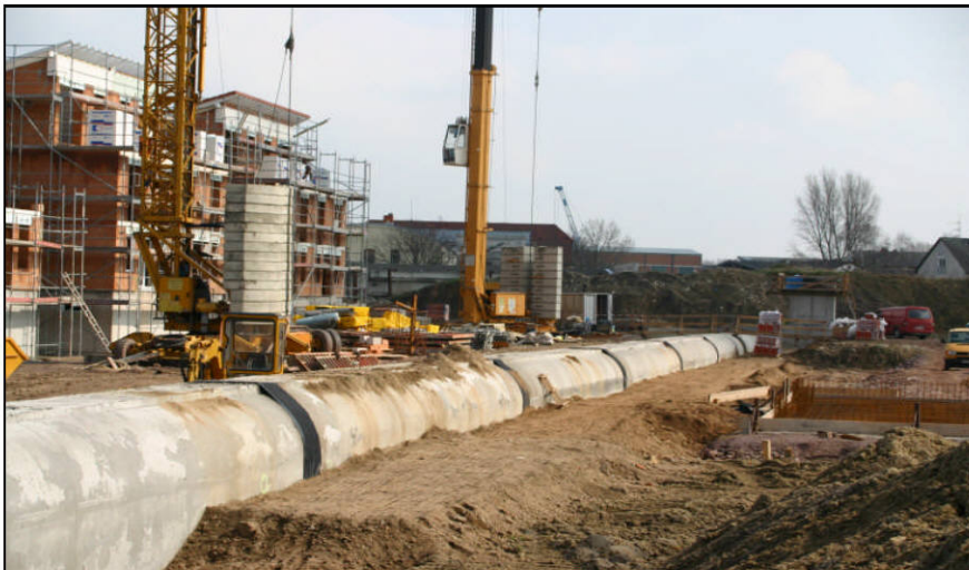
Fertiger ISK in teilverfüllter Bauweise die Stöße mit Schutzfolie überklebt.
