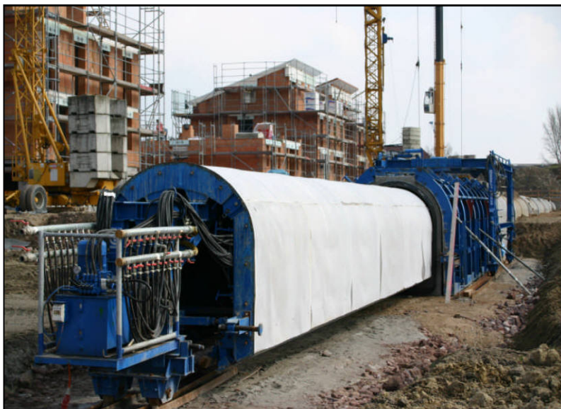
Innenschalungswagen mit Drainagevlies, Außenschalung noch nicht ausgeschalt.
