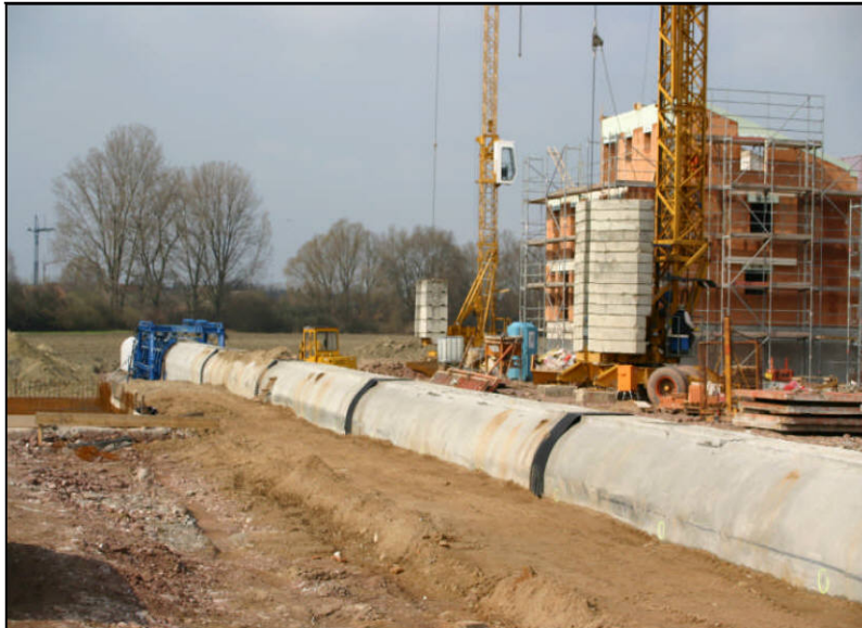
Mehrere Abschnitte ISK zusammen mit Schalungsmaschine am Schluß.
