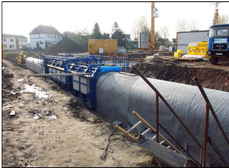
Schalungsmaschine sowie bereits betonierter Kanal mit Luftpolsterfolie abgehängt.
