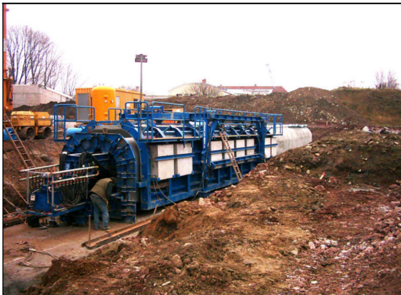
Schalungsmaschine im Zuge des Ausschalens.
