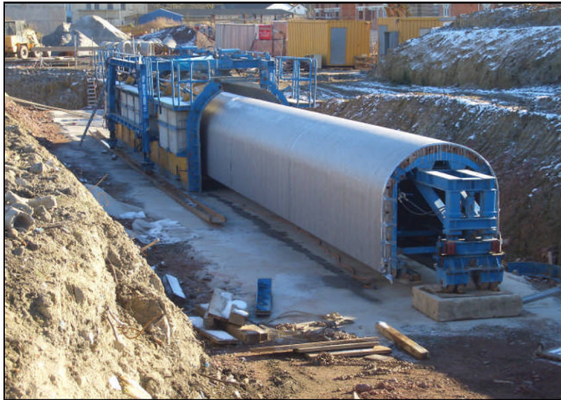
Außenschalung mit Isolierung bisher noch nicht eingeschalt.
