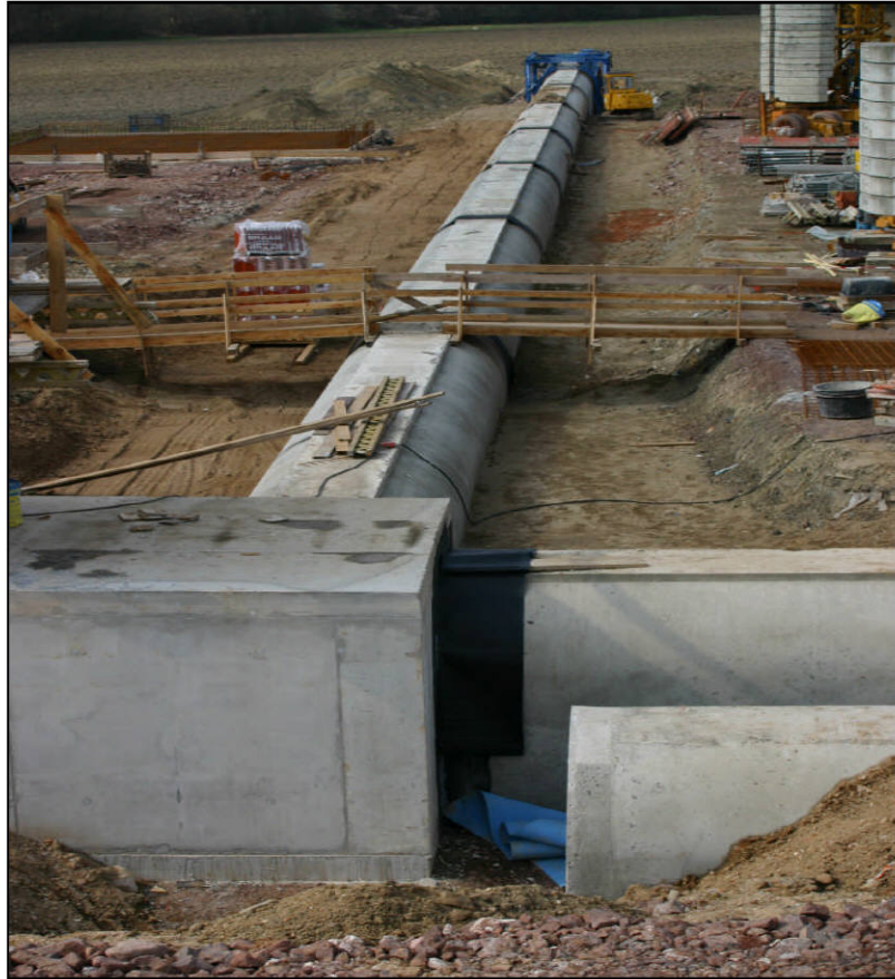
ISK 1 in Ost-/Westrichtung fertigbetoniert, letzter Schuß noch nicht ausgeschalt. Im Vordergrund Einstiegsbauwerk sowie Anschluß Süd-Nordachse ganz im Vordergrund Regenwasserzisterne, alles in teilaufgefülltem Zwischenbaustand.
