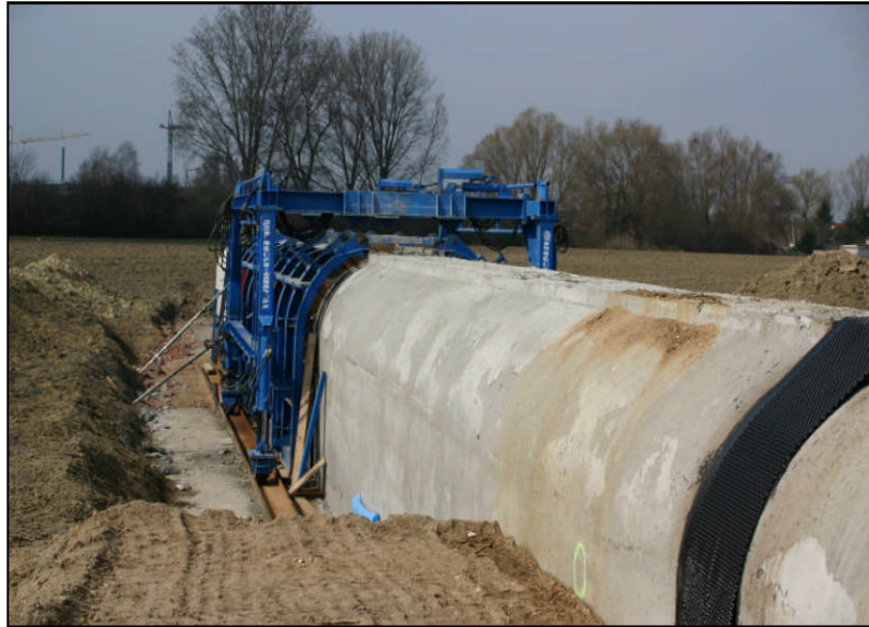
Fertigbetonierter ISK und Schalungsmaschine mit einem weiteren Teilabschnitt eingeschalt.
