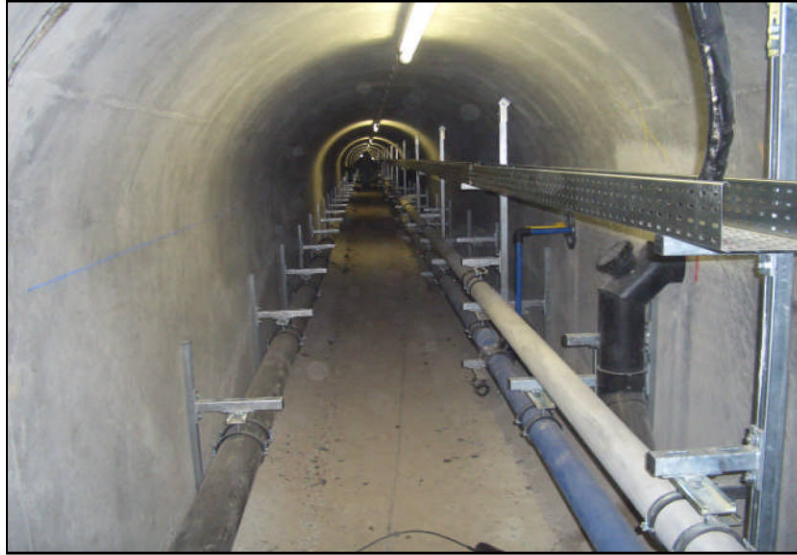
Teilmontierten Zustand des ISK Abwasserleitung 2 hüftig.
