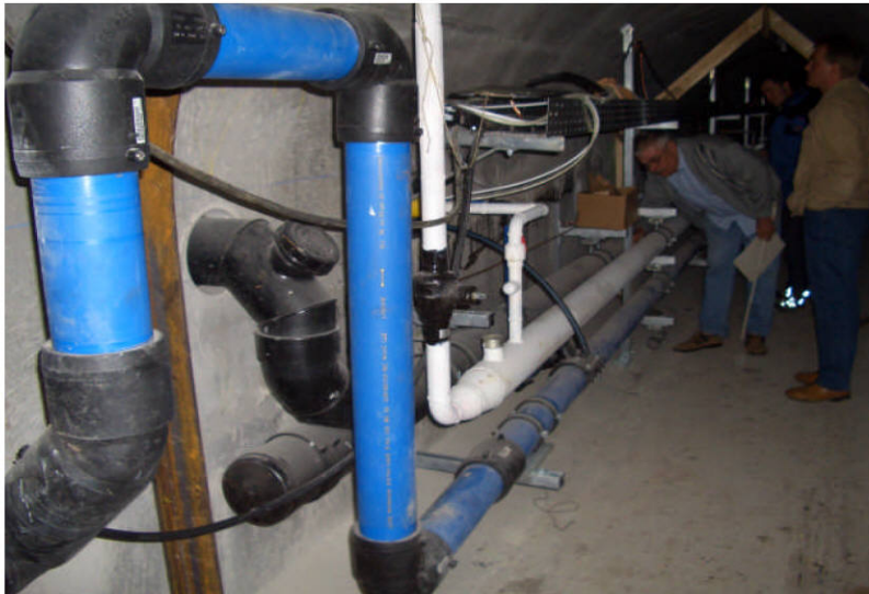
Ende der Installationen im Infrastrukturkanal. Schwarz: Abwasserhausanschluß.
