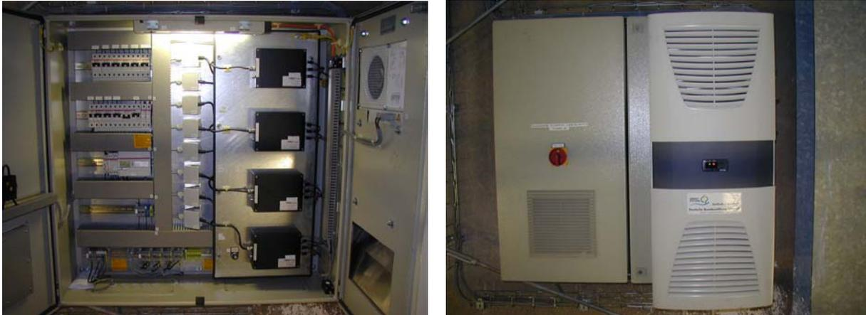
**Abb. 5.1:** Schaltschrank mit nachgerüstetem Klimagerät (Türen offen und geschlossen)
