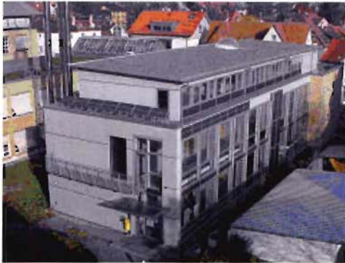
Abb. 1: Versuchs- und Demonstrationsgebäude Technikum „G“ für Gebäudeklimatik.
