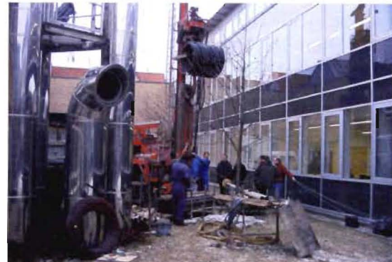
Abb. 2: Bohren einer der beiden 99 m tiefen Erdwärmesonden am Technikum G.
