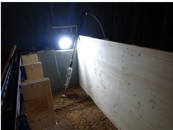
*Bild A5.5 Lagenweises Einbringen und Verdichten des Stampflehms in die vorbereitete Schalung.*
