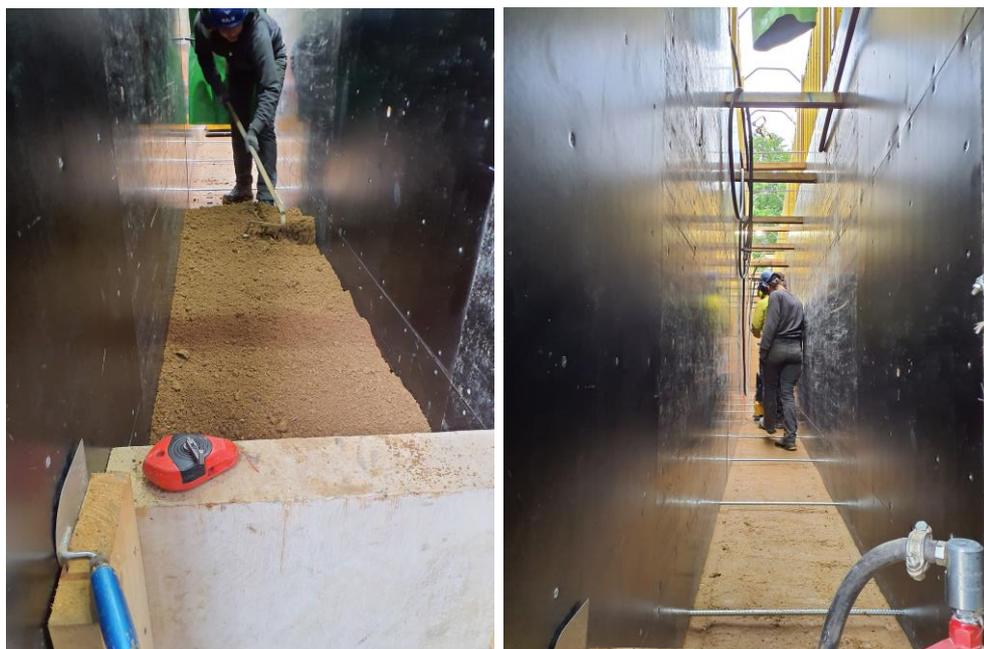
Abb. 22 (links): Ausharken und Homogenisieren des Rohmaterials in der Schalung
