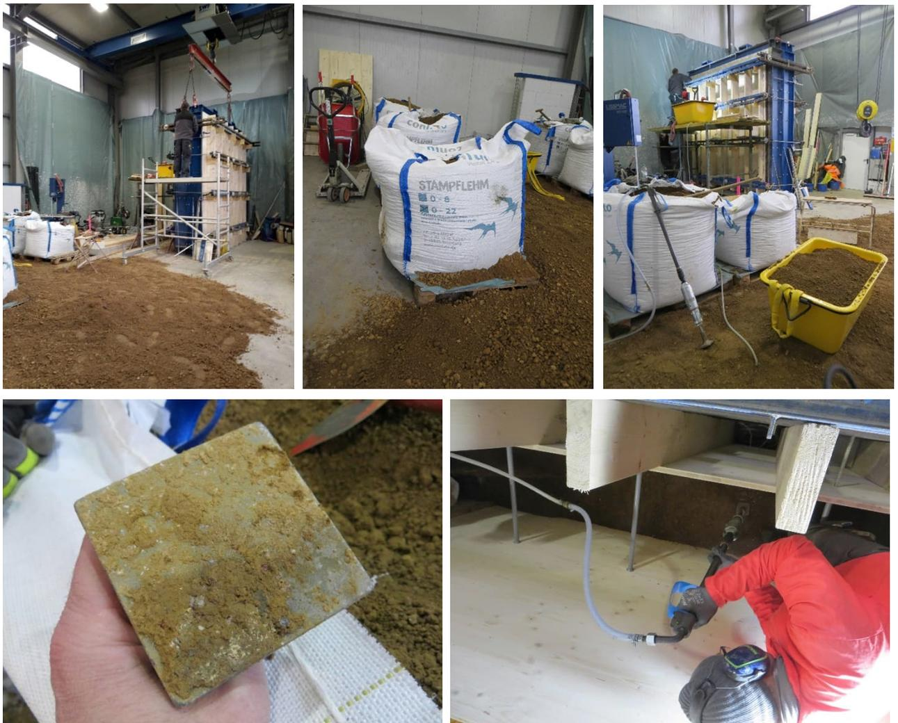
*Bild 26* Zum Trocknen ausgebreiteter Lehm in der Prüfhalle (links oben), Big Bag von Conluto mit Stampflehm der Korngröße 0 – 22 mm (Mitte oben), Bottich mit verarbeitungsfähigem Lehm (rechts oben), Metallstampffuß 8 cm x 8 cm mit deutlich anhaftendem, zu nassem Lehm (links unten) und lagenweises Verdichten der 10... 15 cm dicken „Lockerschichten“ mit dem pneumatischen Stampfer (rechts unten)
