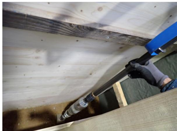
*Bild A5.4 Lagenweises einbringen des Stampflehms mittels pneumatischem Stampfer.*
