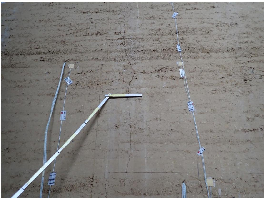
*Bild A6.26 Detail Rissbreite Vertikalriss auf der feuerabgewandten Seite.*
