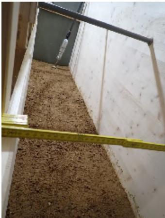
*Bild A5.3 Lagenweises Einbringen des Stampflehms in die vorbereitete Schalung und Darstellung der Wanddicke von 600 mm.*
