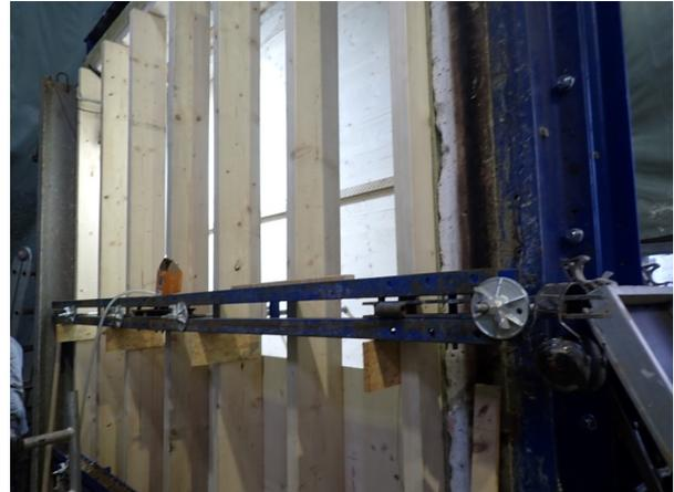
*Bild A5.2 Montage der Schalung für die Erstellung der Stampflehmwand  $d = 600$  mm.*
