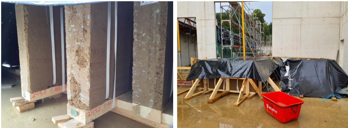
Abb. 7: Lagerung der vorgefertigten Elemente vor Ort
