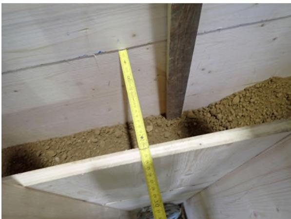
*Bild A5.3 Einbringen des Stampflehms in die vorbereitete Schalung und Darstellung der Wanddicke von 220 mm.*
