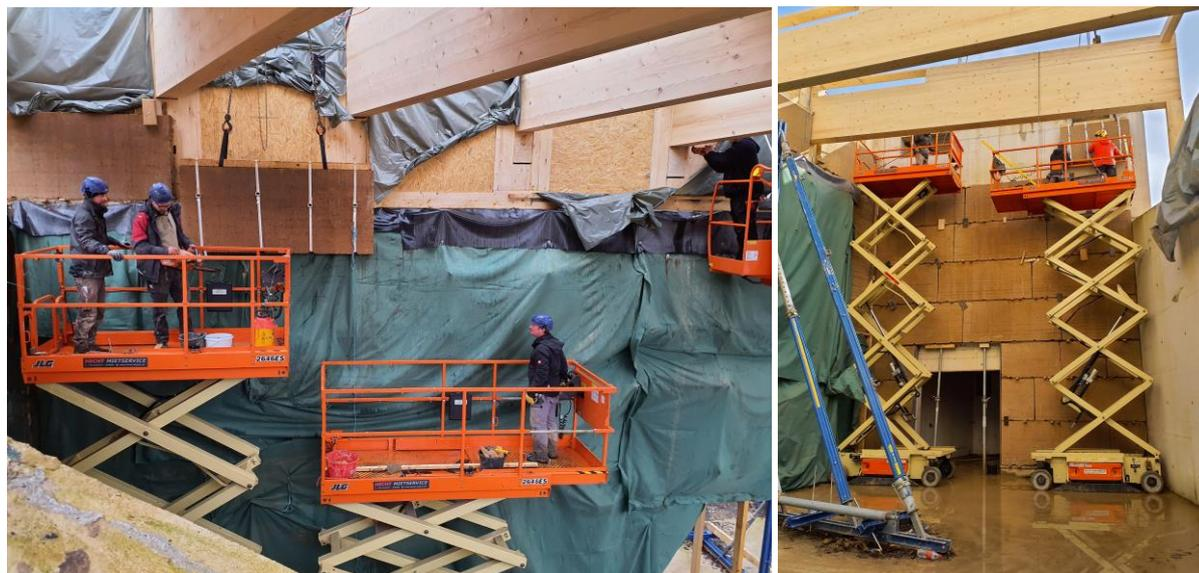
Abb. 8: Montage vorgefertigter Stampflehmelemente
