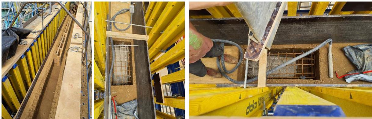
Abb. 25: Stürze und Betonpolster als Auflager
