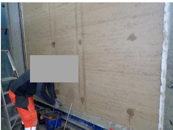
*Bild A5.5 Verschluss der Öffnungen der Schalkonstruktions-Haltestangen.*
