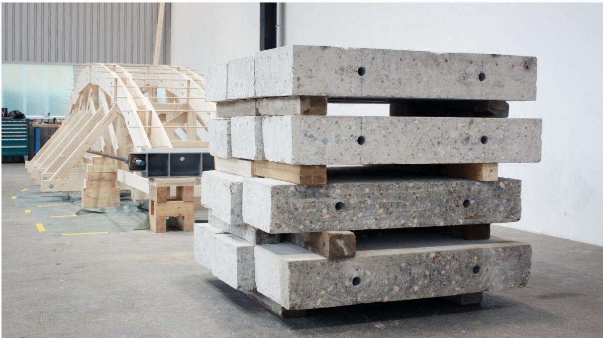
Abbildung 38 Vorbereiten der Betonsegmente für der kleinen Fußgängerbrücke [26]
