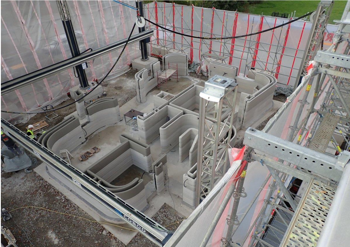
Abbildung 34 Baustelle des gedruckten Hauses in Beckum, Bildquelle Ing.-Büro Schiessl-Gehlen-Sodeikat [24]
