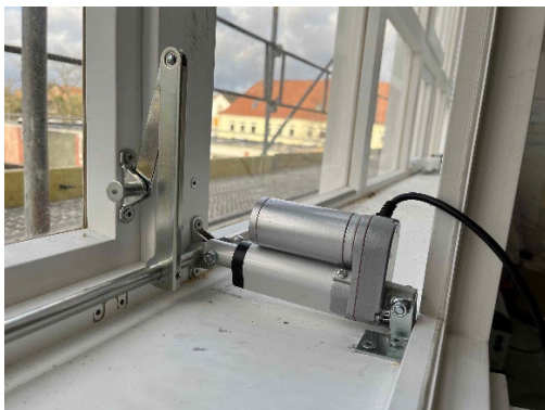
Linearmotor als Antrieb
