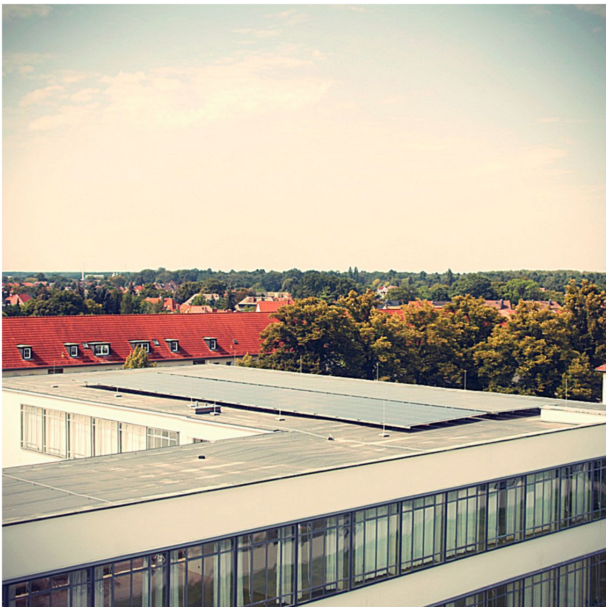
Dachgleiche Photovoltaikanlage auf dem Bauhaus Dessau
