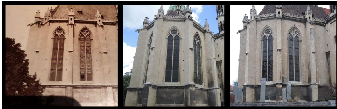
Abb. 11. Aussenansicht des Westchors von Südenwesten. Historisches Foto aus dem 19. Jh., Zustand 2017 mit der Schutzverglasung der 1970er Jahre, Zustand 2019 (v.l.n.r.)
