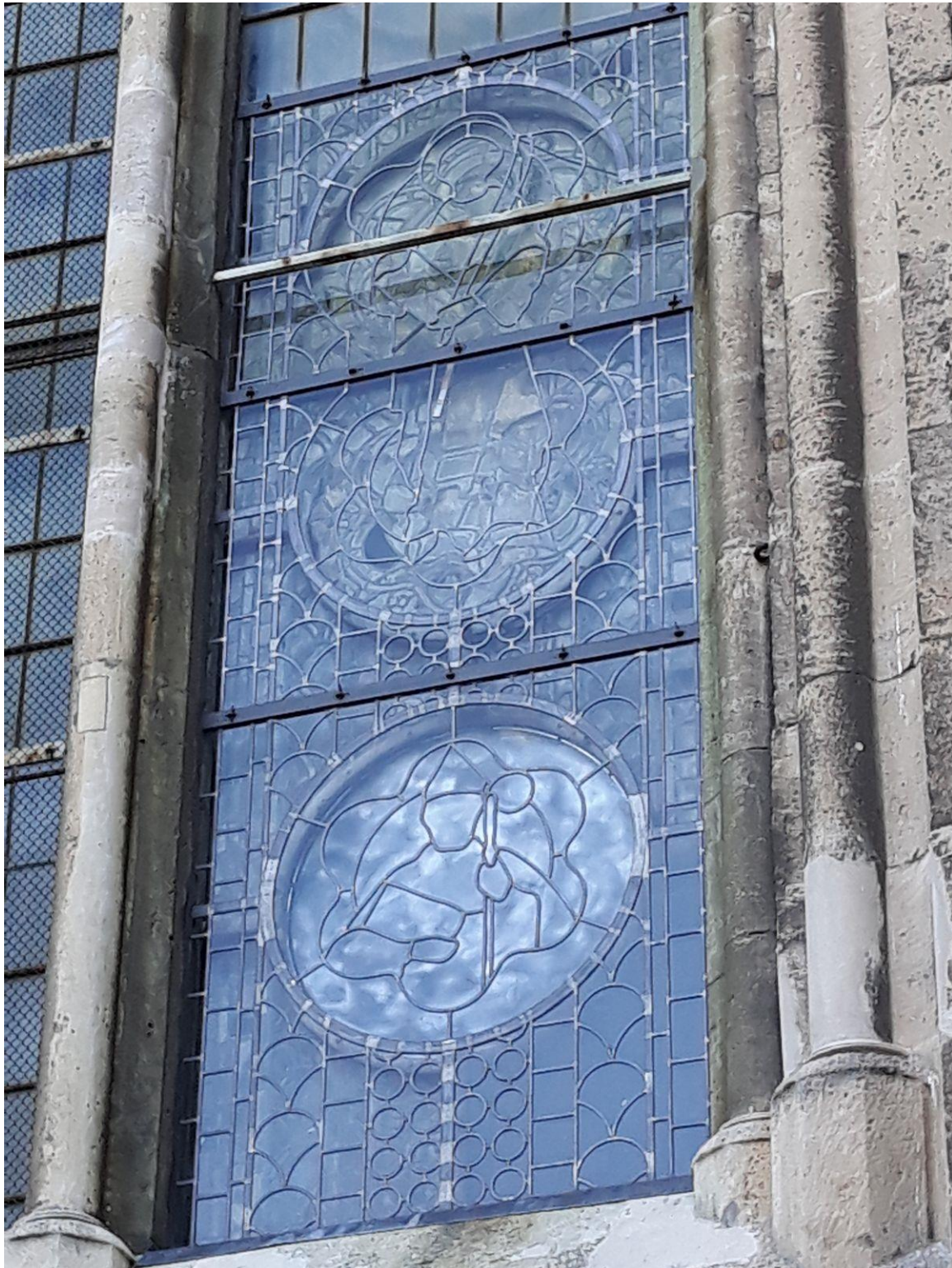
Abb. 8 Testinstallation von verschiedenen Filtergläsern am Naumburger Dom zur visuellen Beurteilung.
